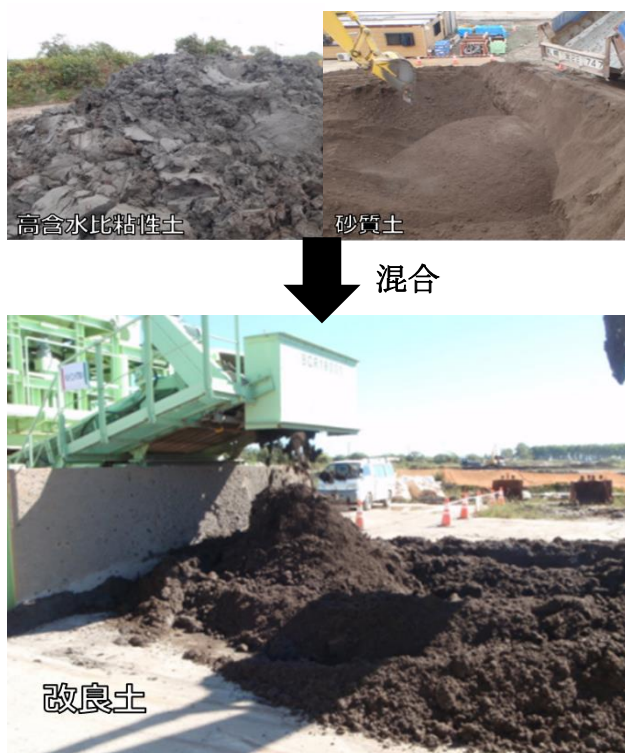
写真-1 高含水比粘性土の改良事例
